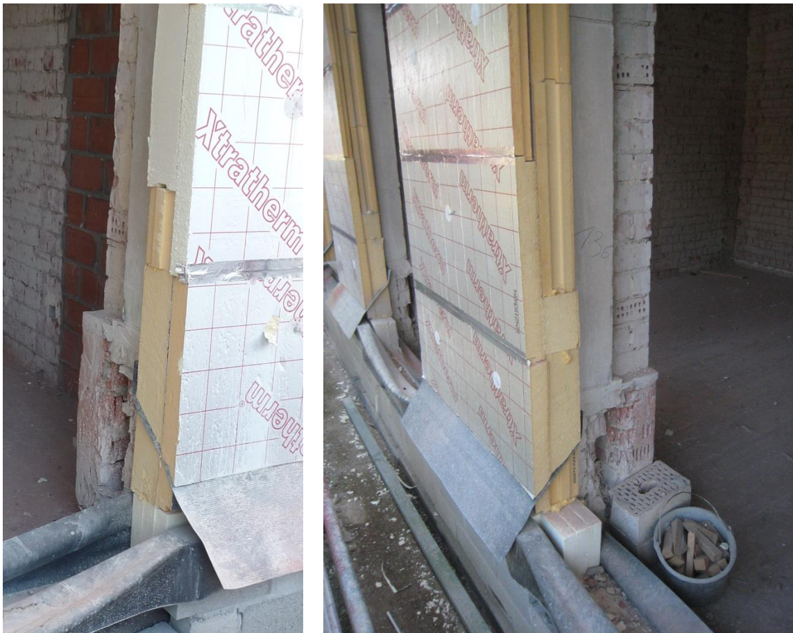
b. Foto: Uitvoering buitengevelisolatie
