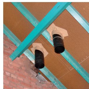
Winddicht afkleven van dakdoorvoeren.
