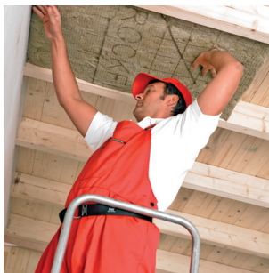
Isolatie tussen de draagstructuur met rotswol. Foto: Rockwool
