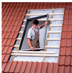
Plaatsing van een isolerend kader. Foto: Velux
