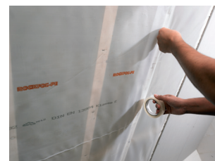
Afkleven van het luchtschermbaan. Foto's: Rockwool
