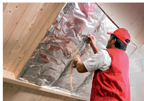
Luchtdicht afkleven van flensdeken. Foto: Rockwool
