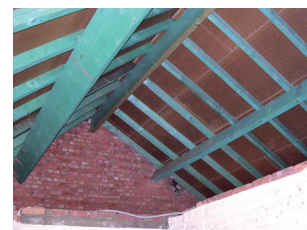
Niet-geïsoleerd keperdak met onderdak.
