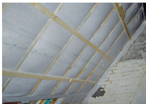
Luchtdicht afgewerkt hellend dak. Foto: E-advies
