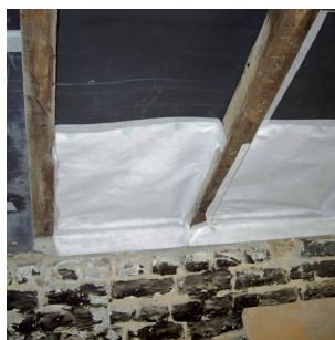
Winddichte aansluiting van het bestaande onderdak op de muurplaat. Foto: E-advies
