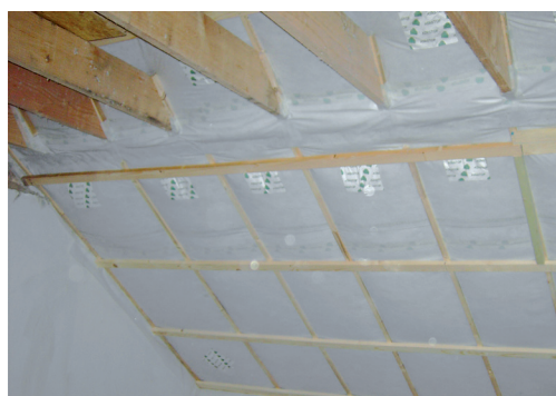
Doorboringen van het luchtschermbaan ter hoogte van de trekbeamben. Foto: E-advies
