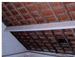
Niet-geïsoleerd keperdak zonder onderdak.
