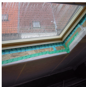
Luchtdicht afkleven ter hoogte van het dakvlakraam. Foto: E-advies
