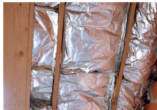
Verkeerd geplaatste spijkerflensdeken. Foto: Rockwool
