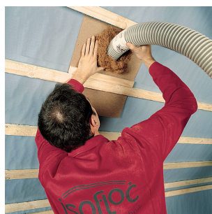
Inblazen papiervlokken in een hellend dak. Foto: isofloc
