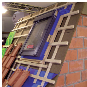
Winddicht afkleven ter hoogte van het dakraam.
