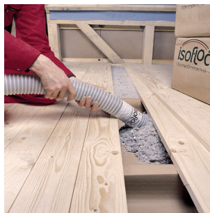
Zoldervloer isoleren tussen de draagstructuur met papiervlokken. Foto: isofloc
