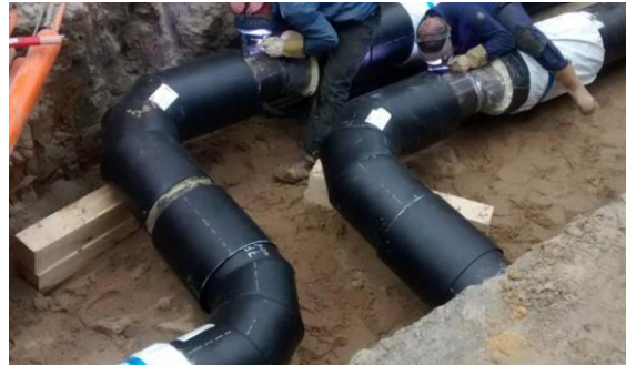
Een warmtenet in aanleg (bron Ingenium)
