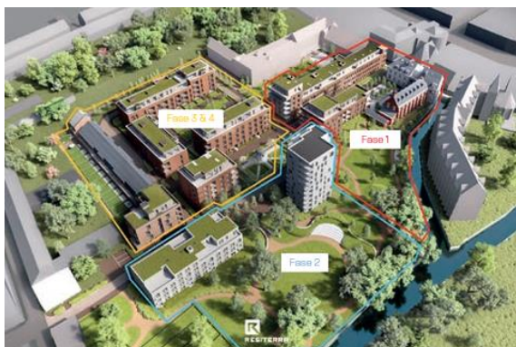
Janseniusshof in Leuven: Energienet met als warmtebronnen geothermie (KWO) en aquathermie (beeld Ingenium en Resiterra)
