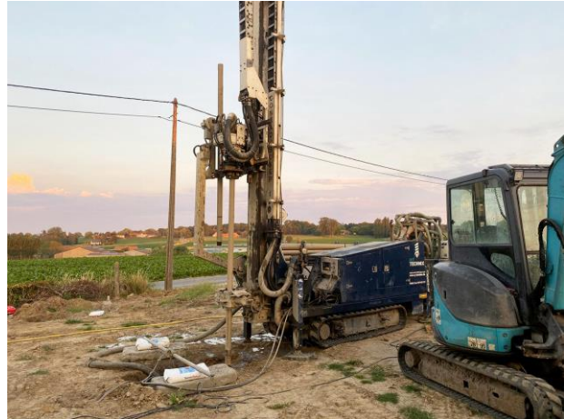
Het maken van een geothermieboring (BEO) (bron bouwenaanvlaanderen.be)
