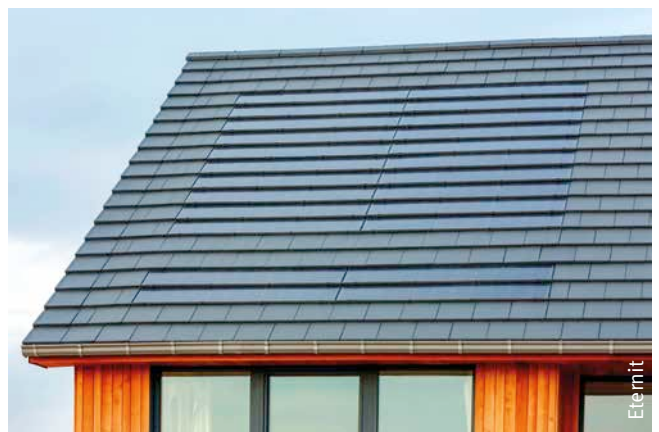
Afb. 8 Zonnepanelen die geïntegreerd werden in de dakbedekkings-elementen en algemeen zicht op een fotovoltaïsche installatie die geïntegreerd werd in een dak.
