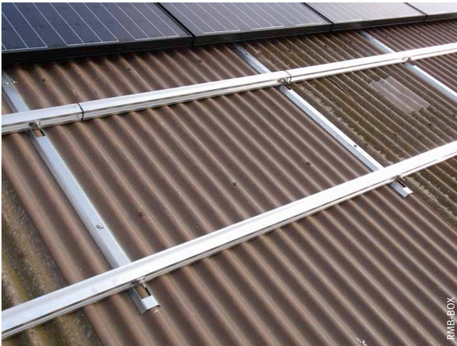
Afb. 18 Ander bevestigingsmiddel voor gebruik op golfplaten en geprofileerde platen.
