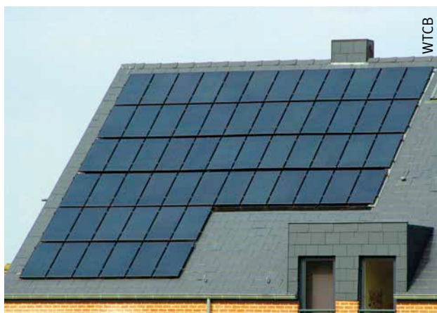
Afb. 10 Montage van fotovoltaïsche panelen door semi-integratie in de dakbedekking.
