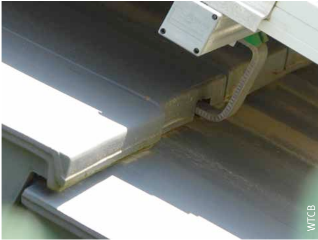
Afb. 27 Aanpassing van de dakpan om de doorgang van de haak mogelijk te maken.
