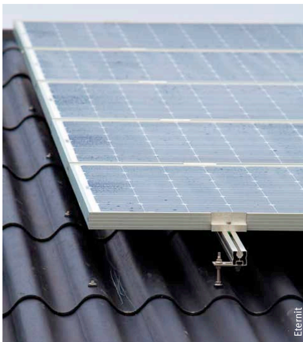
Afb. 16 Bevestiging van zonnepanelen met behulp van deuvels op golfplaten.
