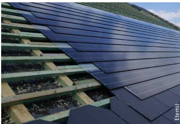
Afb. 8 Zonnepanelen die geïntegreerd werden in de dakbedekkings-elementen en algemeen zicht op een fotovoltaïsche installatie die geïntegreerd werd in een dak.
