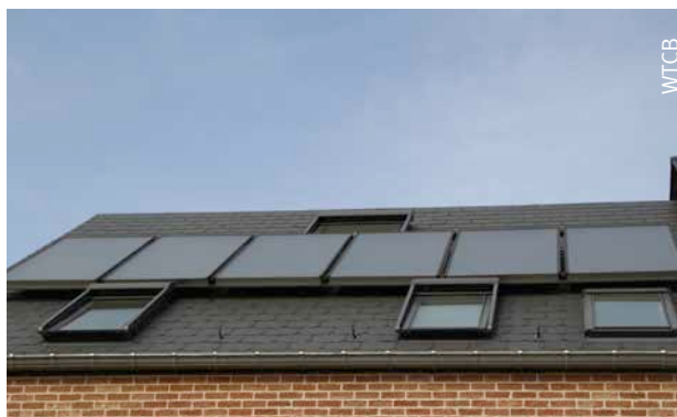
Afb. 4 Bovenop de dakbedekking geplaatste zonnecollectoren.
