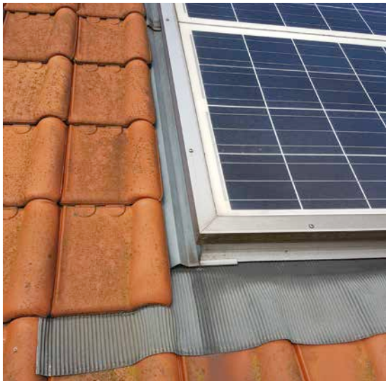
Afb. 46 Overlapping aan de onderrand met behulp van een metaalfolie.
