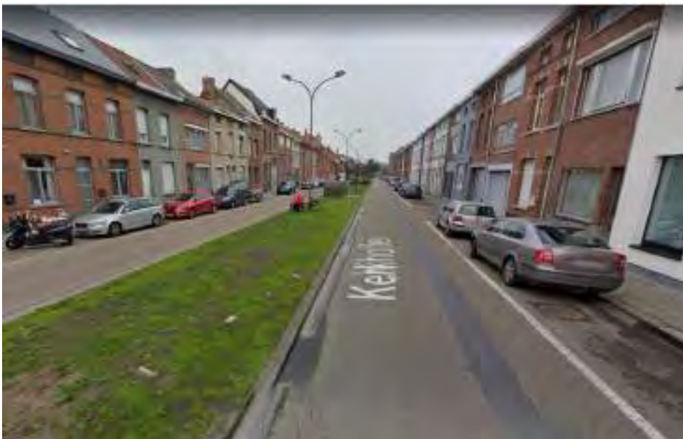
Figuur 7.25: Groene middenberm in de Kerkhoflei. De groene middenberm zorgt voor minder verharding en afstroom, maar de verharde weg watert nog wel af via de goot naar de riolering en niet naar de onverharde middenberm (Bron: Google streetview).
