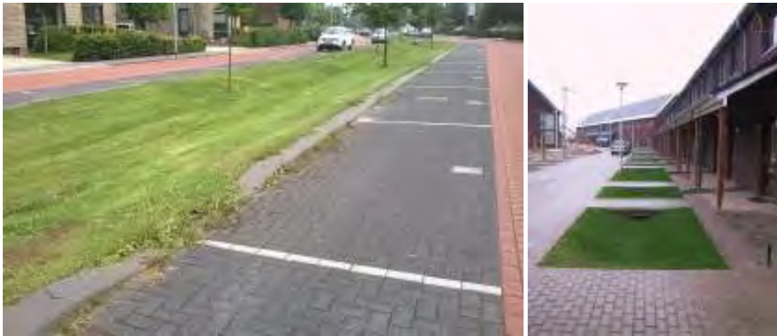
Figuur 6.10: Inspiratiebeeld van rechtstreekse infiltratie waarbij wegdek en parkeerplaatsen rechtstreeks afwateren richting de verlaagde groenzone (links) en onrechtstreekse infiltratie waarbij dakwater wordt afgeleid naar een gemeenschappelijke groenzone (Bron: Sweco)
