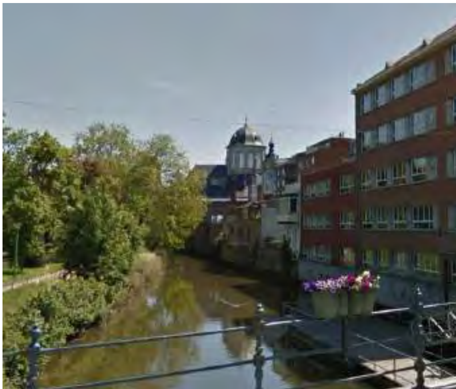
Figuur 7.18: Inspiratiebeeld - Gebouwen waarvan de overloop dakwater (na bronmaatregelen volgens GSVH) rechtstreeks zou kunnen afwateren naar de waterloop.
