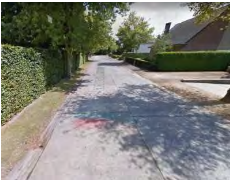
Figuur 7.42: Voorbeeld van locatie waar weg lokaal naar de bermen zou kunnen afwateren in wijk Muizenhoek (Bron: Google streetview).
