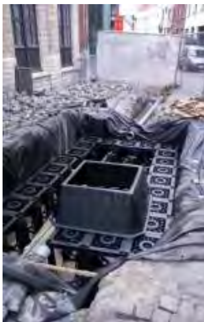
Figuur 6.12: Detail ondergrond boombunker hallestraat (Bron: stad Mechelen)
