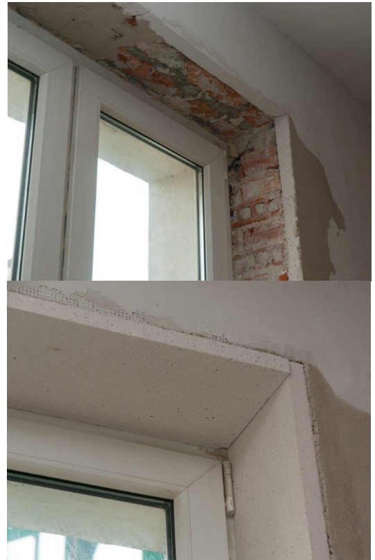
Koudebruggen wegwerken ter hoogte van de raamaansluitingen (foto's: Xella)
