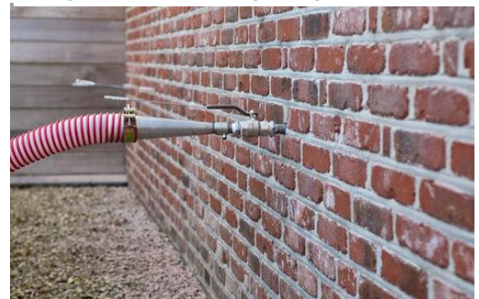
Vullen van de spouw via de vulopeningen (foto: Isolblow)
