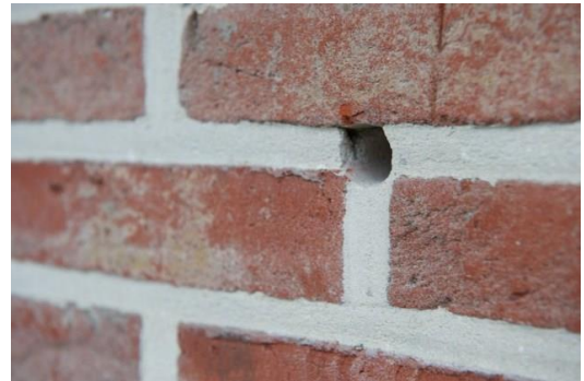
Op de kruising van lint- en stootvoegen van de gevelsteen worden gaten geboord. (Foto:
