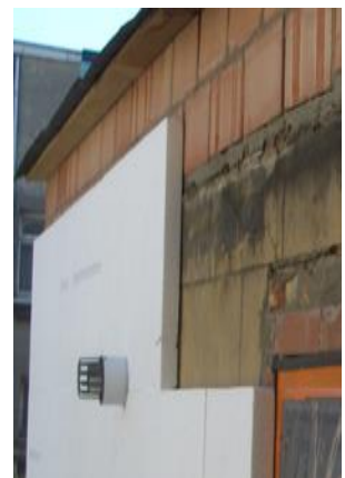
Buitenisolatie met EPS-platen (foto: LEHR)
