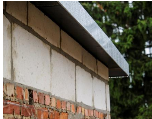
Isolerende bouwblokken en dakoversteek voor het plaatsen van buitenisolatie (foto: Lander Leekx)
