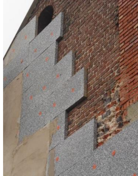
Bestaande volle muur isoleren door buitenisolatie (foto: Iso-Klus)
