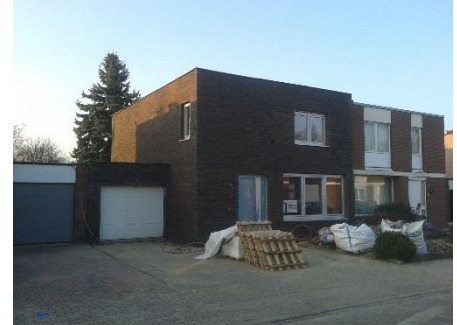
Buitenisolatie met steenstrips (foto's: De Jaegere JP architectenbureau)
