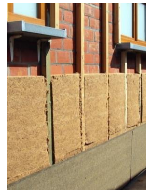
Verticaal enkelvoudig keperwerk met isolatie en windscherm.
