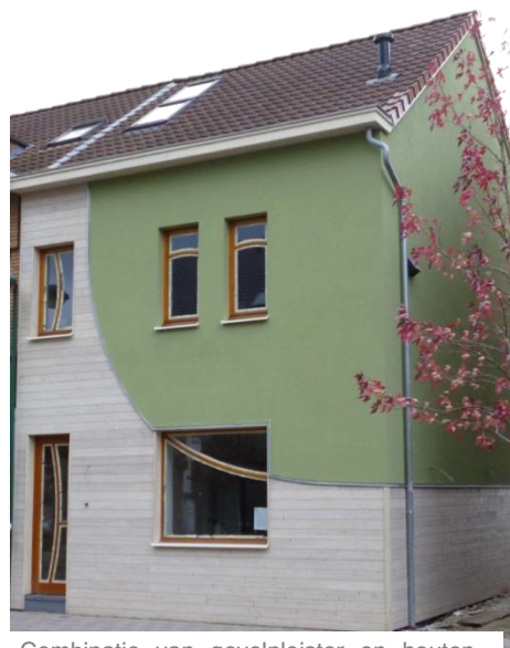
Combinatie van gevelpleister en houten beplanking (arch. D. Van Clé)
