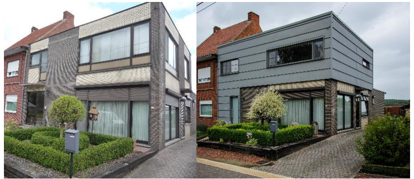
Renovatie met gevelbekleding in zink met staande naad (arch. D. Van Clé – foto's: Steunpunt DUBO Vlaams-Brabant – Lander Loeckx)
