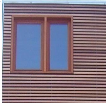
Horizontale gevelplanken met open voegen (foto: Van Laer, Inter)
