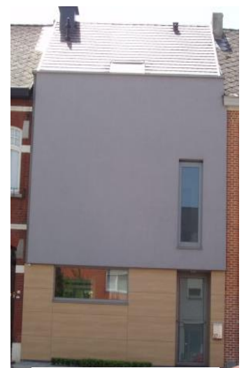
Onderaan: harsgebonden cellulosevezelplaten
