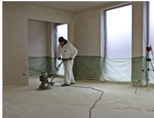
Opschuren van het uitgehard PUR schuim om tot een vlak oppervlak te komen (afbeelding: Isofloor)
