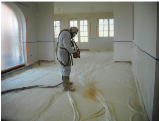
Spuiten van PUR schuim op de dekvloer, over de technische leidingen (afbeelding: GT foam)
