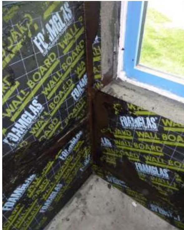
Afbeelding 175 :praktijkvoorbeeld van een raamaansluiting met celloglas [ref. PCE, project 't Balanske, Wingene]
