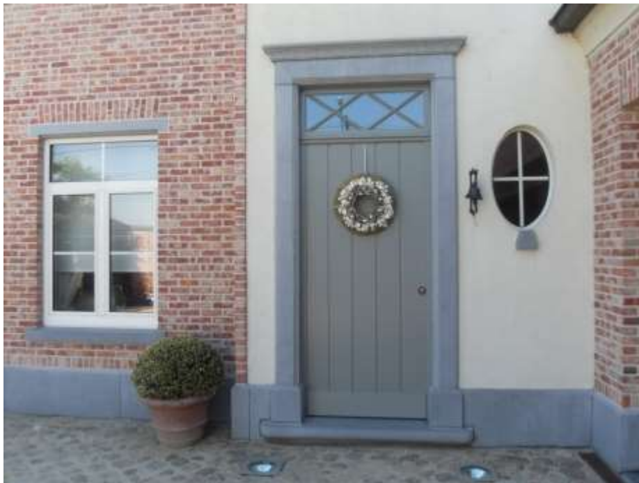
Afbeelding 36 : perimeterisolatie kan geïntegreerd worden in een gevel via een plint (voorbeeld van een plint in blauwsteen in traditionele woningbouw [foto: Nijst-natuursteen.be])
