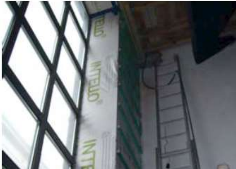
Afbeelding 181 : praktijkvoorbeeld van een raamaansluiting met binnenisolatie op basis van cellulose [ref. Presentatie IsoproC, "Isoleer uw buitenmuren!", 27.05.2009]
