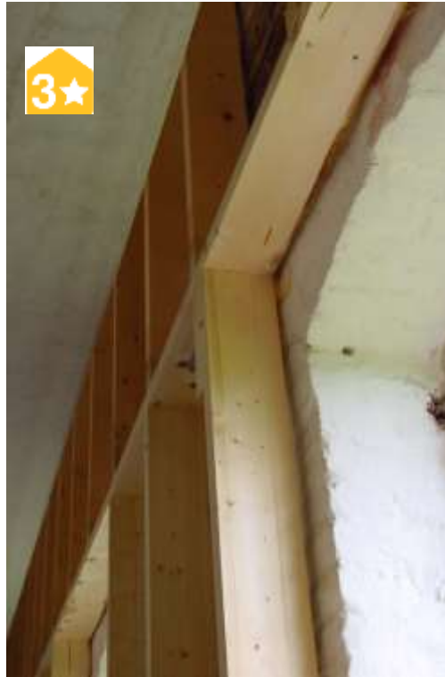
Afbeelding 85 : praktijkvoorbeeld van het doortrekken van binnenisolatie over een massieve vloer: een houtskeletwand als basis voor binnenisolatie loopt door tussen oude massieve muur en nieuwe vloerelementen in beton [ref. IsoproC, binnenisolatie werf Schlachthof, Eupen, 2002]
