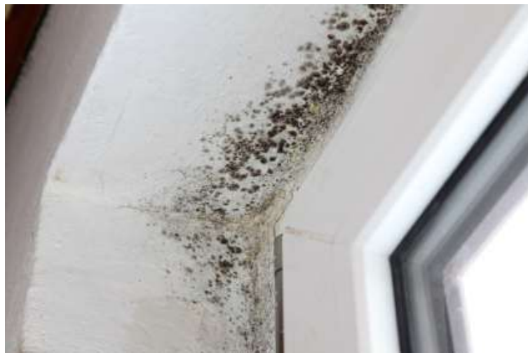
Afbeelding 1 : schimmelgroei op een niet-geïsoleerde dagkant [foto WTCB, L. Lassoie]
