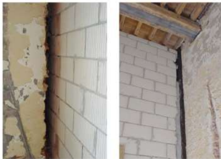
Afbeelding 68 : continuïteit van de binnenisolatie via doorkappen inbindende muur (praktijkvoorbeeld) [ref. Presentatie IsoproC, "Isoleer uw buitenmuren!", 27.05.2009]
