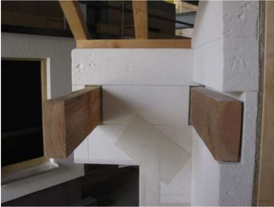
Afbeelding 141 : balkkop en strijkbalk
