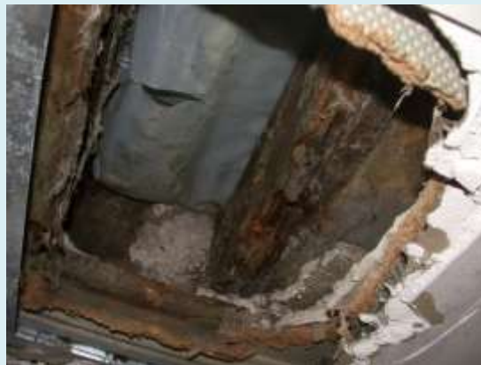
Afbeelding 48 : houtrot in een houten vloer boven een kelder [foto WTCB, L. Firket]
