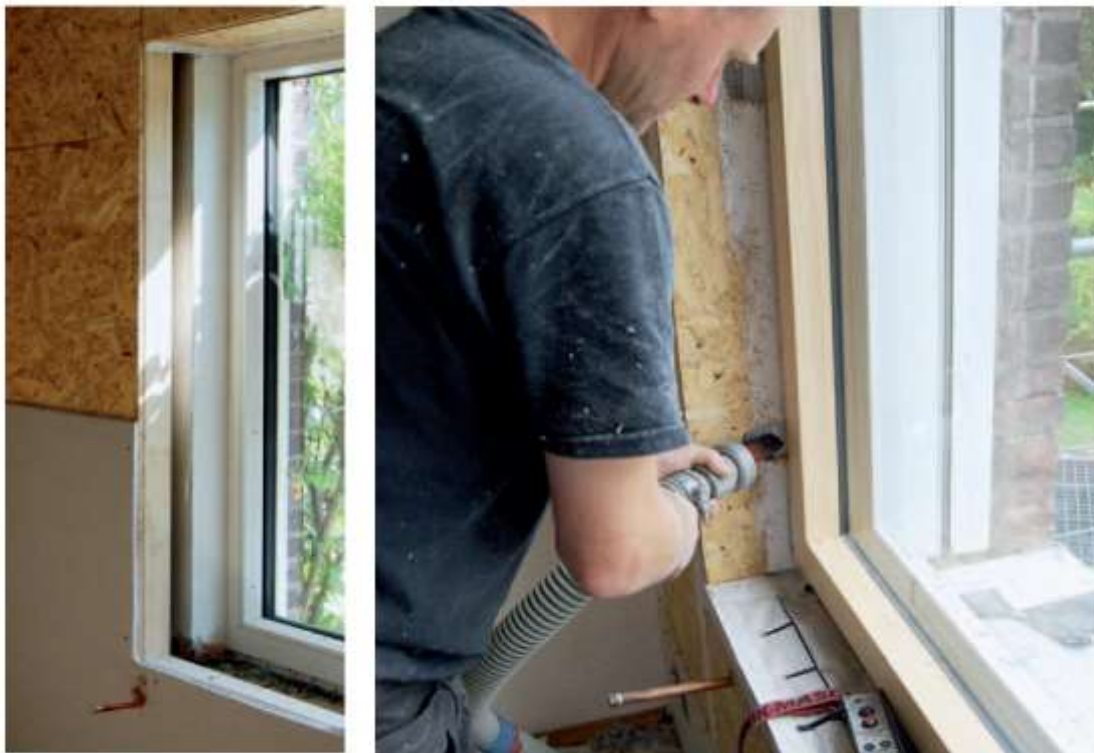
Afbeelding 170: voorbeeld van een vensteraansluiting met binnenisolatie met cellulose (houten stijl- en regelwerk 140 mm, OSB beplating + gipskartonplaten [bron: Holzbau, die neue Quadriga, 5/2009, blz. 18
