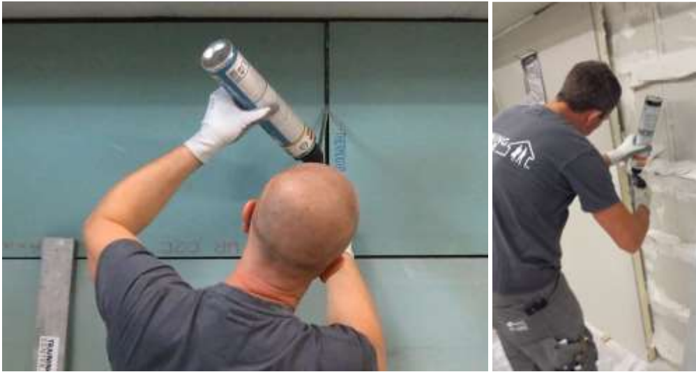
Afbeelding 21 : afdichten van voegen tussen prefab-platen d.m.v. PUR-schuim
