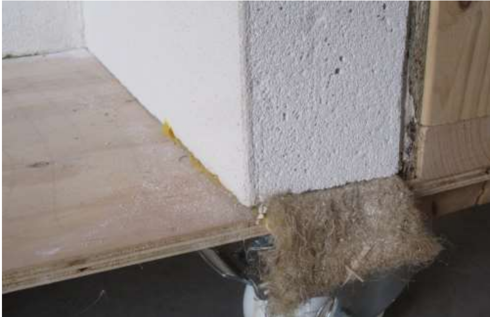
Afbeelding 58 : aansluiting van een binnenisolatie met capillair-actief materiaal op een massieve vloer; detail van een courante techniek voor de realisatie van een luchtdichte aansluiting: strook vilt tussen de isolerende blokken en een massieve vloer (hier voorgesteld door een multiplex plaat); de strook vilt doet ook dienst als desolidarisatiestrook voor het opvangen van eventuele onregelmatigheden in het vloeroppervlak en als akoestische scheidingslaag
