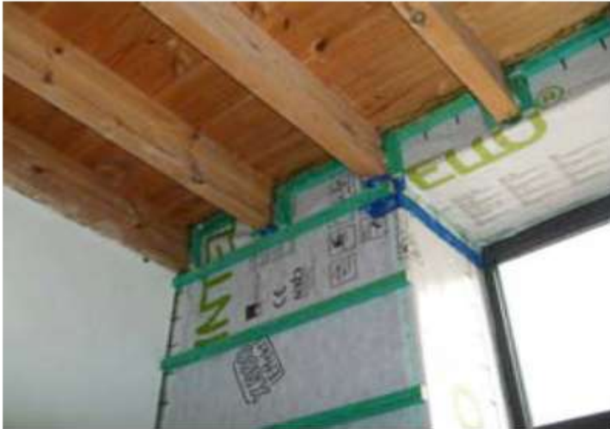
Afbeelding 137 : praktische illustratie van het principe voorgesteld in afbeelding 111 [ref. Presentatie IsoproC, "Isoleer uw buitenmuren!", 27.05.2009]
