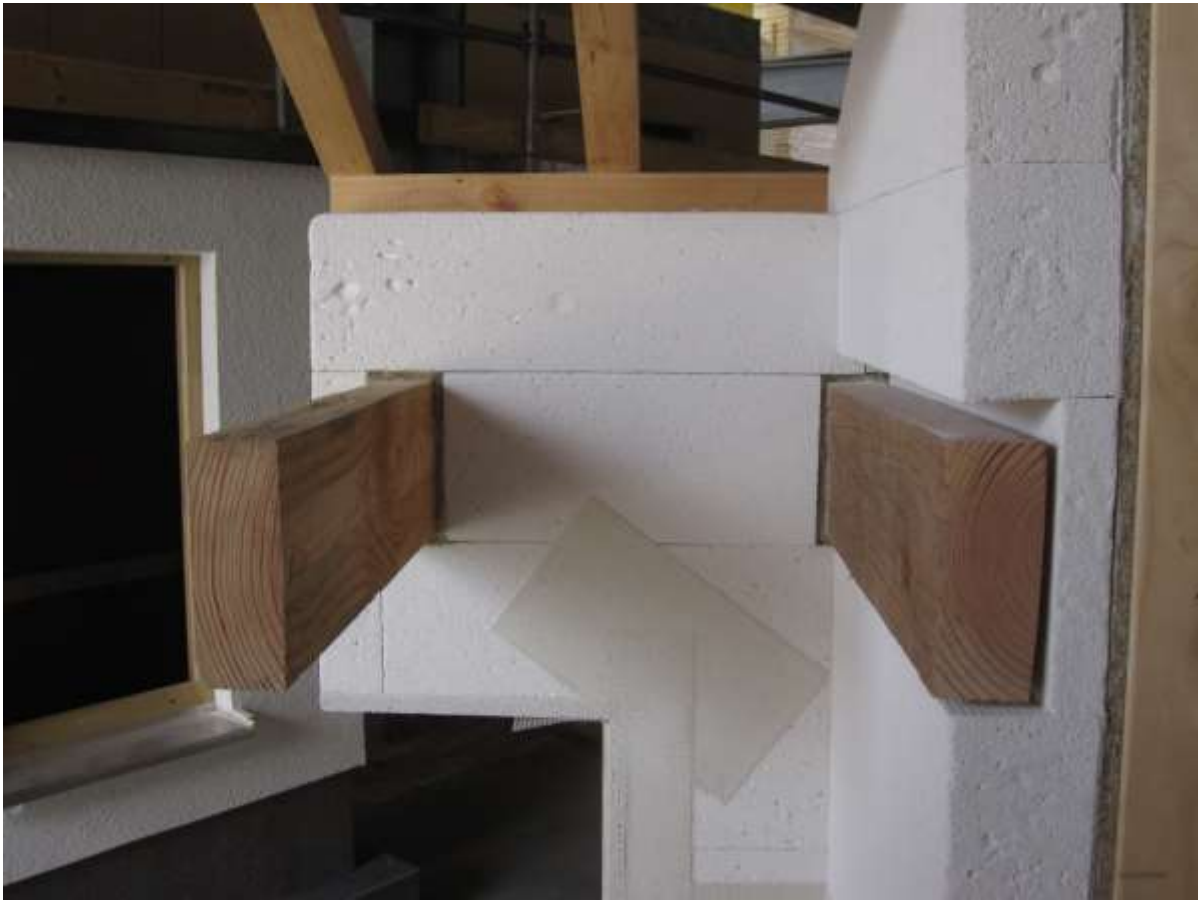
Afbeelding 150 : aansluiting capillair actieve binnenisolatie op dakisolatie: situatieschets
