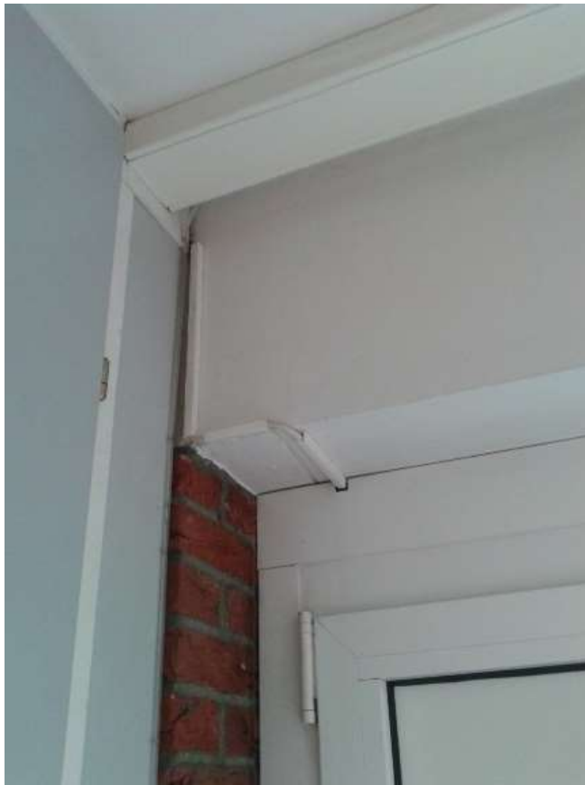
Afbeelding 200 : voorbeeld van een situatie waarbij in het kader van binnenisolatiewerken redelijkerwijs geen isolatie tussen raamprofiel en metselwerk geplaatst kan worden
