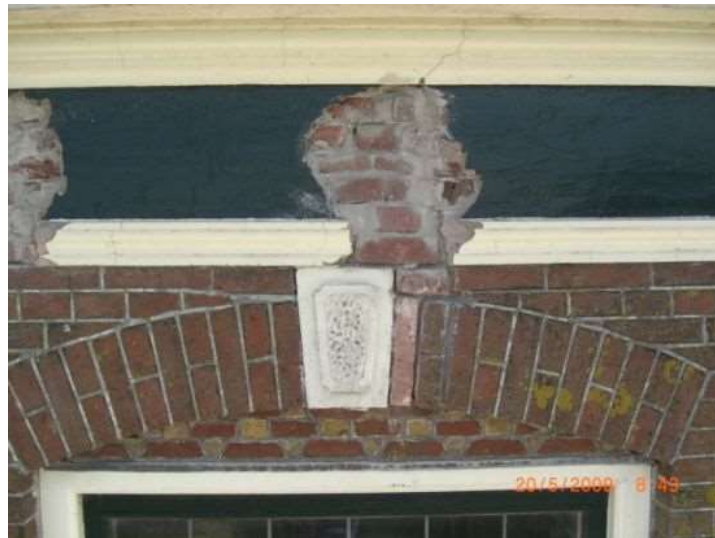
Afbeelding 106 : voorbeeld van een gevel met sierlijst en (blind)ankers, in herstelling tijdens restauratiewerken [ref. http://www.meerbouw.com/ren_min_ovz.php?pj_ID=27 ]
