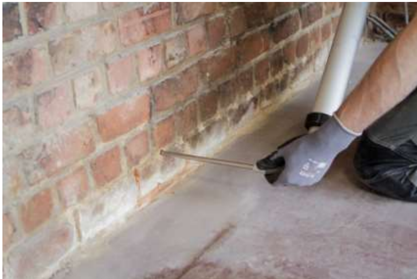
Afbeelding 31 : voorbeeld van het injecteren van een muurvoet
