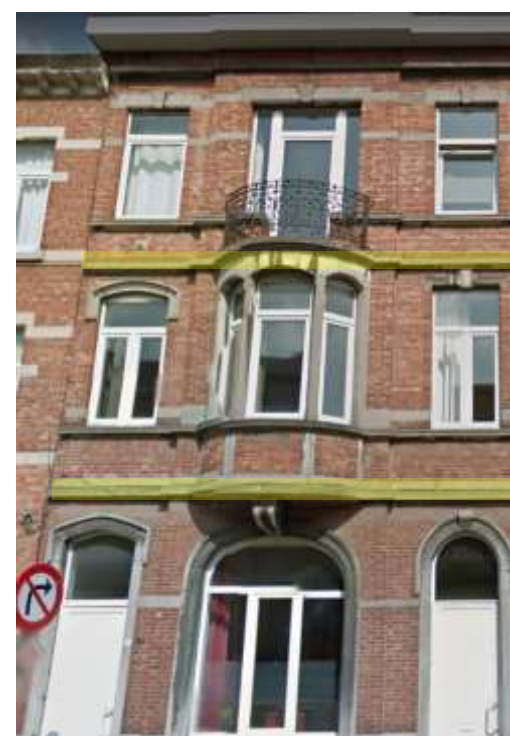
Afbeelding 64 : koudebrug inbindende muur of vloer gereduceerd door lokale strook buitenisolatie (schematische voorstelling); bemerk dat dit in bepaalde gevels architecturaal geïntegreerd kan worden (onopvallend, of juist als decoratief element);
