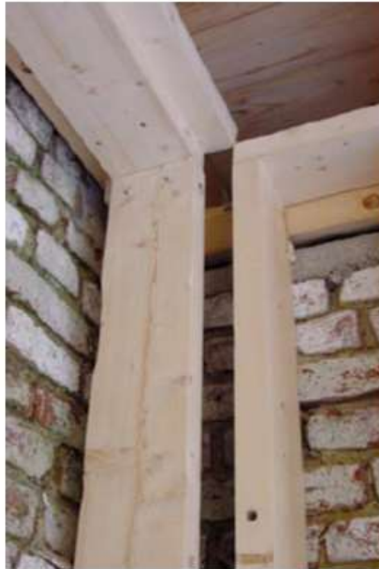
Afbeelding 10 : Praktijkvoorbeeld (houten stijl- en regelwerk waartussen cellulose-isolatie ingeblazen zal worden) [foto: IsoproC]
