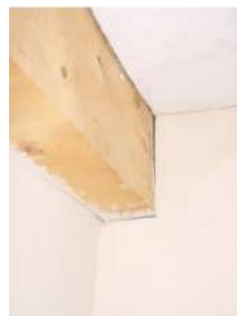
Afbeelding 99 : mogelijke oorzaken van luchtlekken ter hoogte van balkkoppen:
