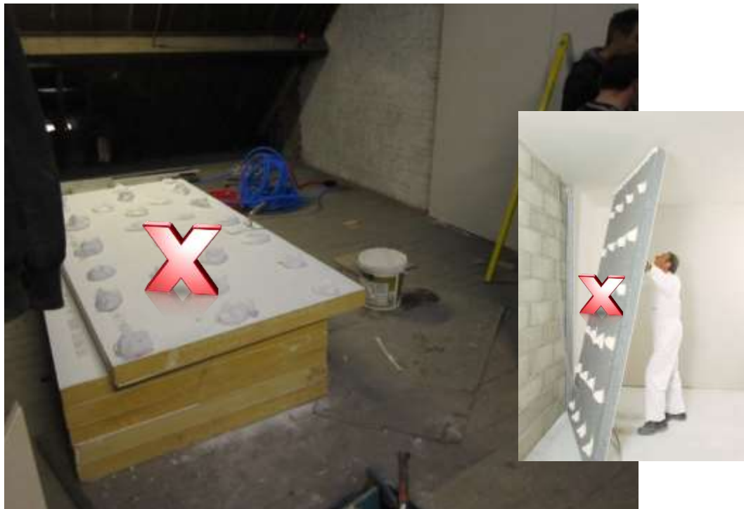
Afbeelding 18 : het (alleen) dotsgewijs verkleven van de plaat is af te raden
