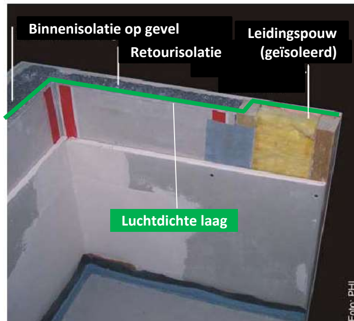
Afbeelding 67 : voorbeeld van de integratie van een leidingspouw in een muur in het verlengde van de retourisolatie [ref. Altbauhandbuch, PHI, 2009, foto arch. Werry, LUWOGÉ]
