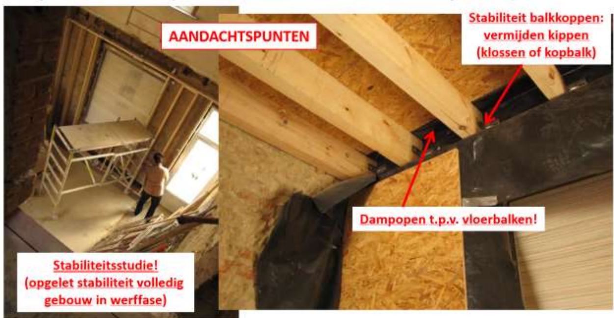
Afbeelding 132 : praktijkvoorbeeld van het volledig vervangen van een houten verdiepingsvloer en het aanbrengen van een nieuwe vloer, steunend op een houtskeletbouw voorzetwand [foto ir.-arch. F. Dobbels]
