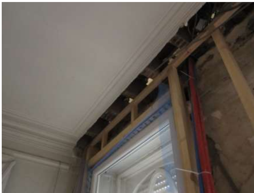
Afbeelding 138 : praktijkvoorbeeld van binnenisolatie met stijl- en regelwerk in een restauratieproject in Brussel; om de isolatielaag continu door te trekken t.p.v. de verdiepingsvloer werd de bekleding van het plafond en van de bovenbekleding van de verdiepingsvloer weggenomen (in latere fase werd ook de plafonddecoratie hersteld) [foto WTCB], arch. Lowette]
