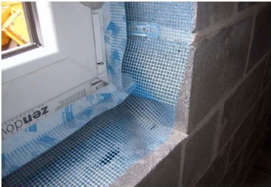
Afbeelding 156 : inpleisterbare aansluitbanden voor luchtdichtnig [ref. Presentatie IsoproC, "Isoleer uw buitenmuren!", 27.05.2009]
