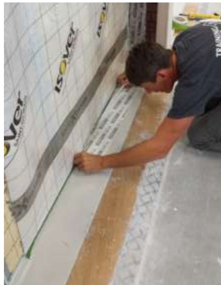
Afbeelding 52 : aansluiting van het luchtscherm op de vloer via zelfklevende luchtdichtingsstroken
