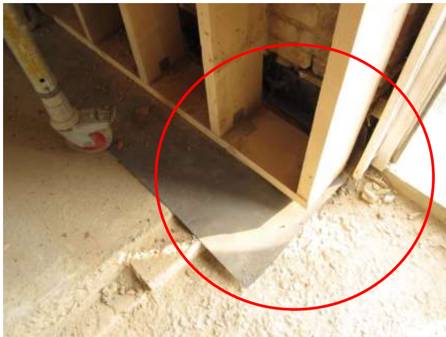
Afbeelding 191 : praktijkvoorbeeld van een aansluiting deur – binnenisolatie in een kleine verbouwing [foto ir.-arch. F. Dobbels]
