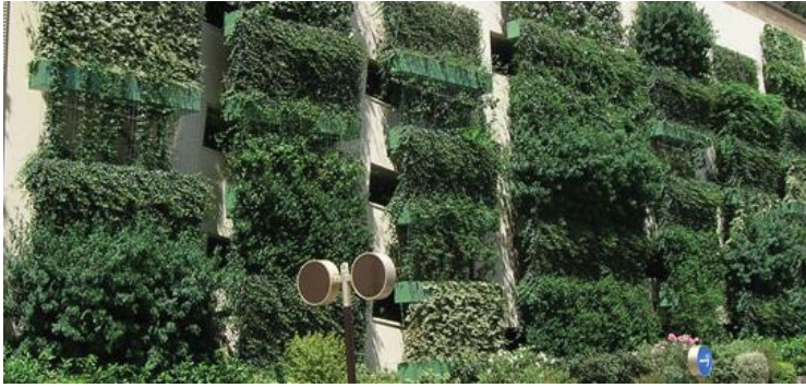
Begroende gevel met behulp van plantenbakken (afbeelding: groentac.be)
