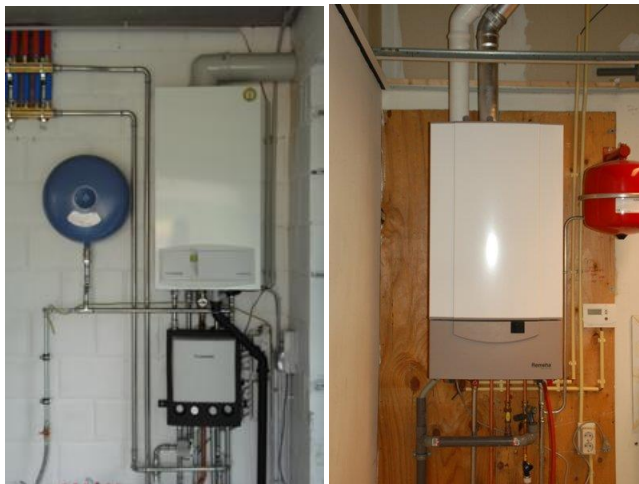
Concentrische / Parallelle buizen voor rookgasafvoer en luchttoevoer
