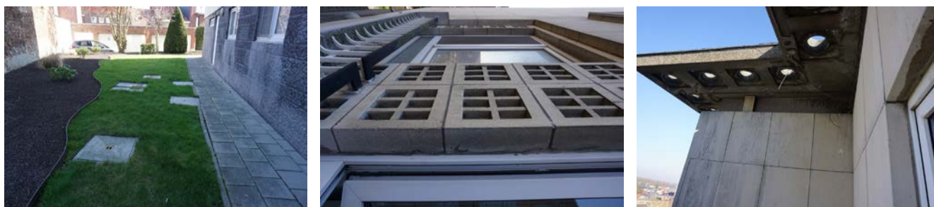
Foto's huidige bouwtechnische staat Casestudy Oliveten III
