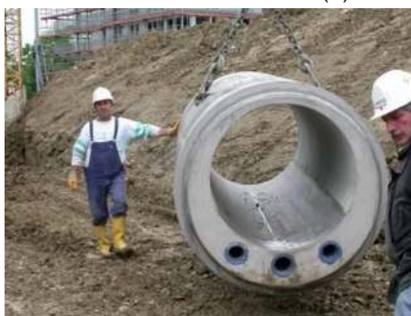
(c) Collector in afvoerbuis
